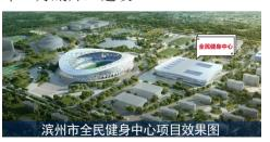
该项目总建筑面积85331.67 m², 地上4层, 地下1层, 地上结构总高度为21.5m, 地上建筑东西长179m, 南北宽144m, 地上及地下室钢结构部分全部由山东滨博杭萧负责生产、安装。项目建成后, 将作
